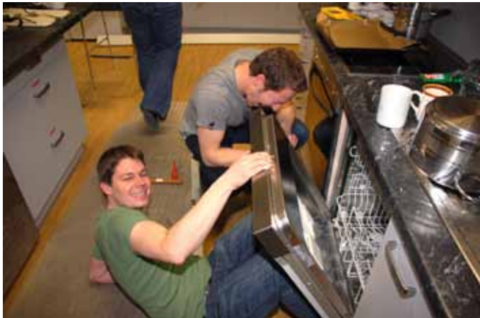
Voller Einsatz beim Einbau des Geschirrspülers
